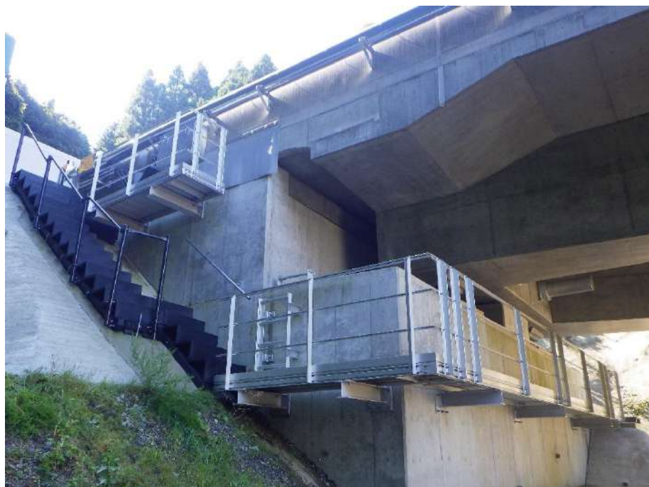
橋梁階段 (下地: シールコンクリート)
