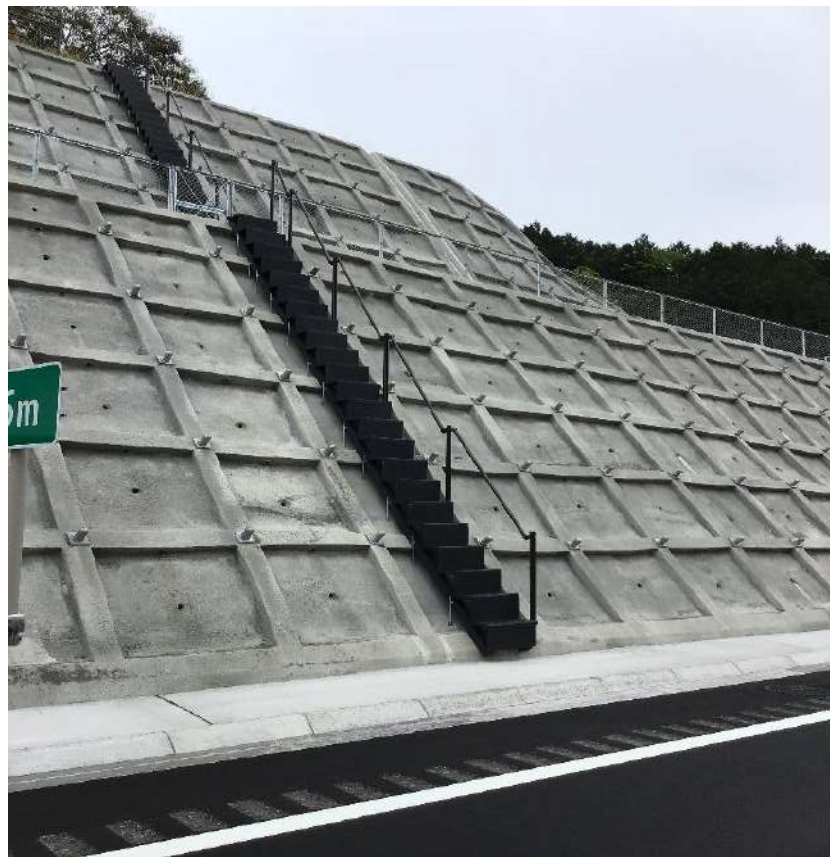
コンクリート法枠面 鉄筋杭使用
