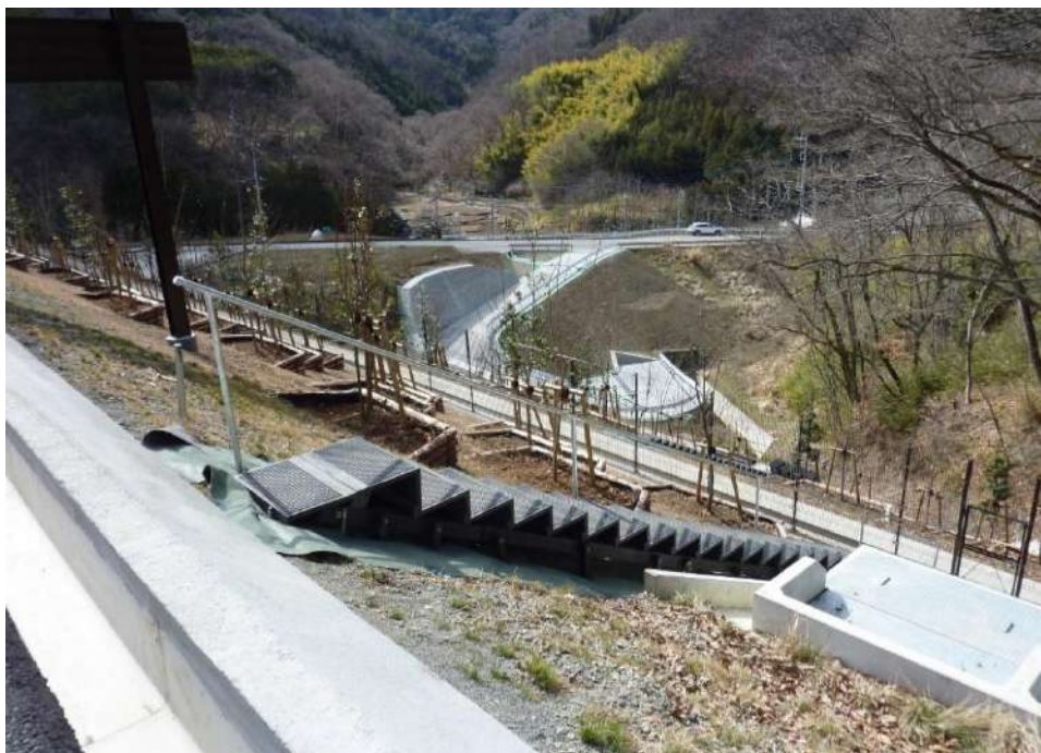
フラットでなく 硬い地山取付
